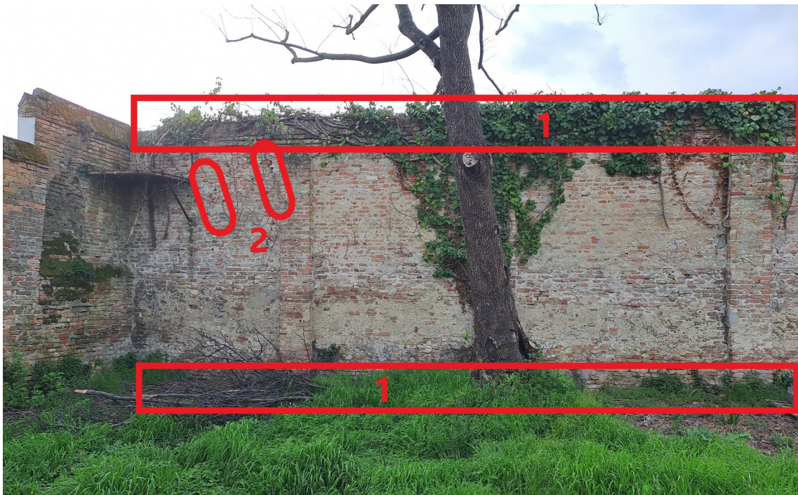
Figura 1: interventi scuci-cuci (vista dall'interno del muro)
