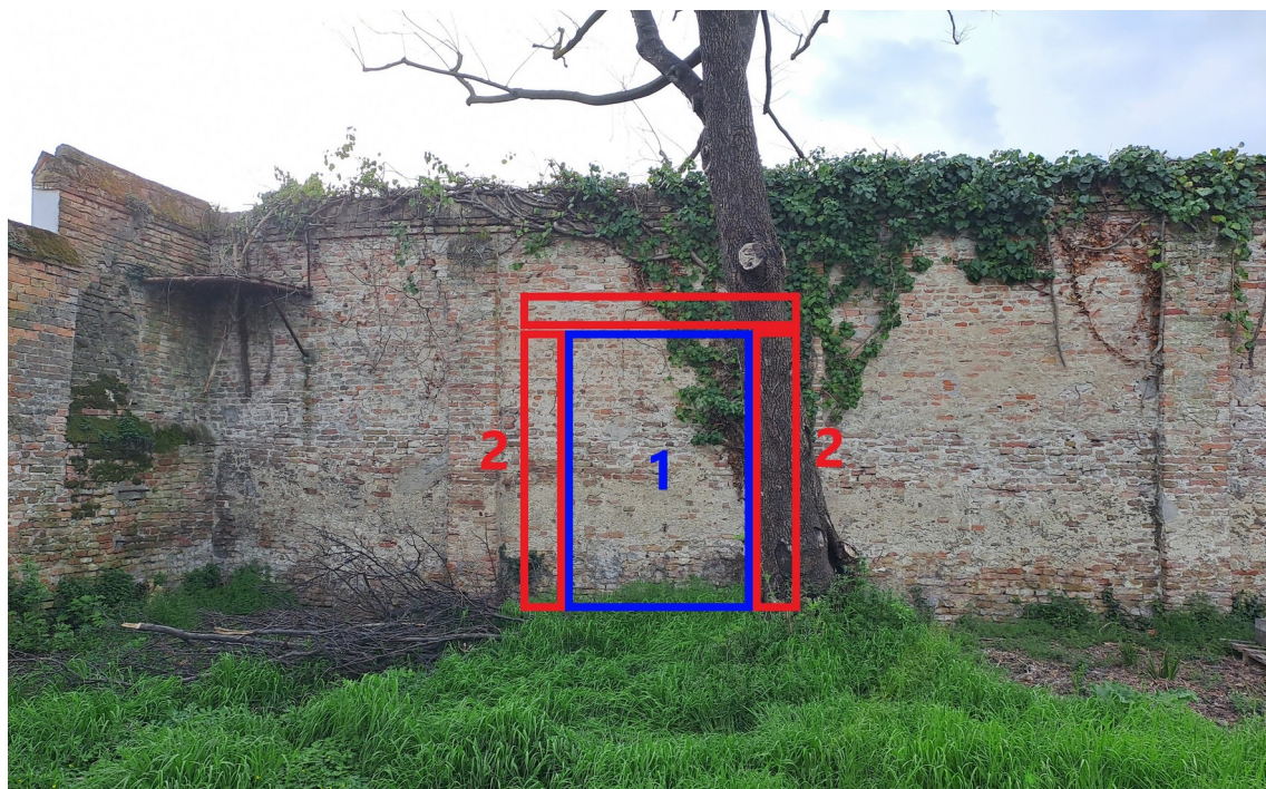
Figura 2: intervento nuova apertura nel muro (vista dall'interno)
